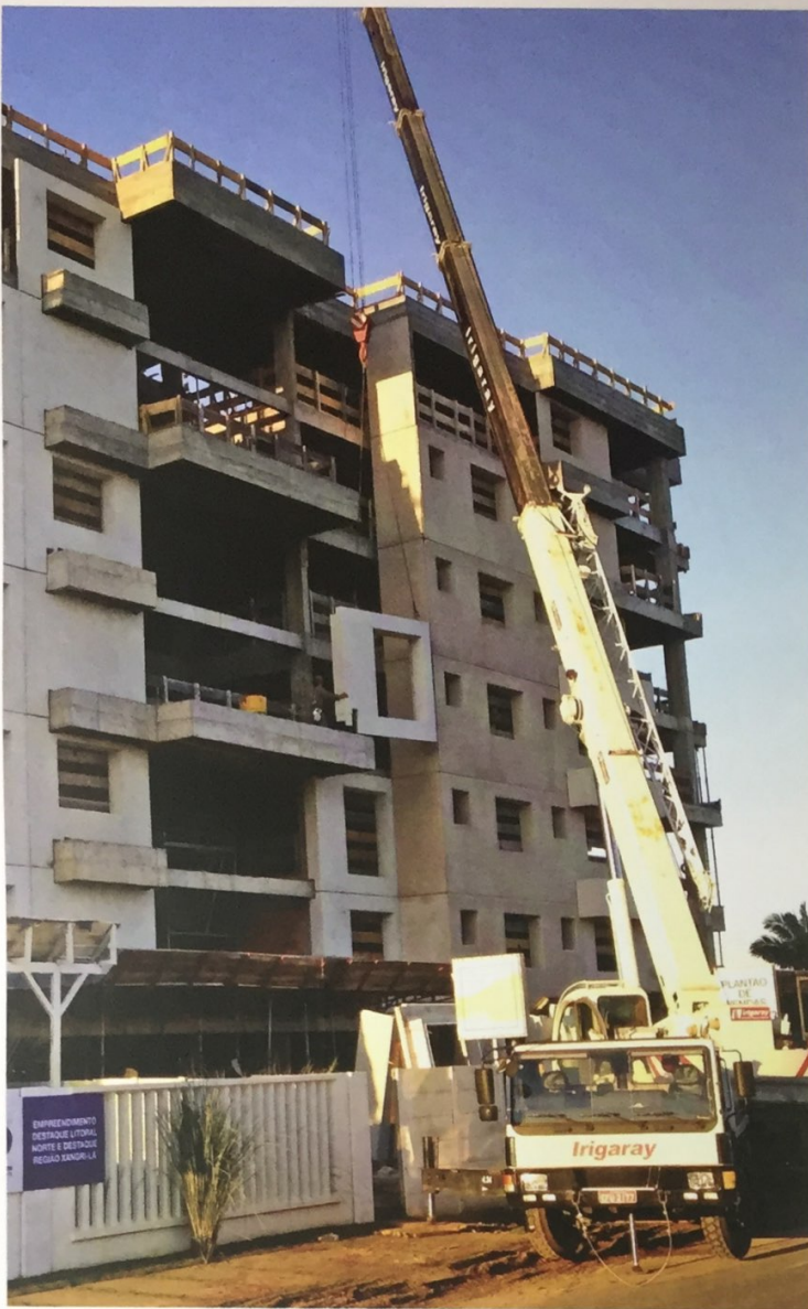
Obras do condomínio Atlântida Green Square
